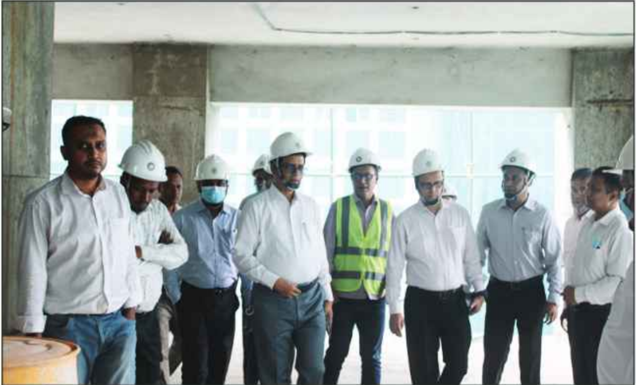
নির্মাণাধীন যমুনা ভবন, কাওরান বাজার, ঢাকা পরিদর্শন করছেন বিপিসি'র চেয়ারম্যান জনাব আমিন উল আহসান এবং ব্যবস্থাপনা পরিচালক জনাব মুস্তফা কুদরুত-ই-ইলাহী।
